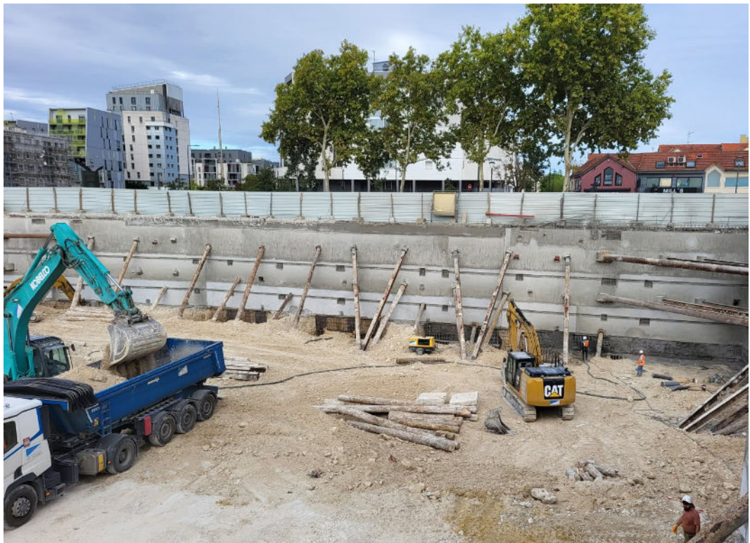
Chantier de l'opération de reconversion à Colombes
