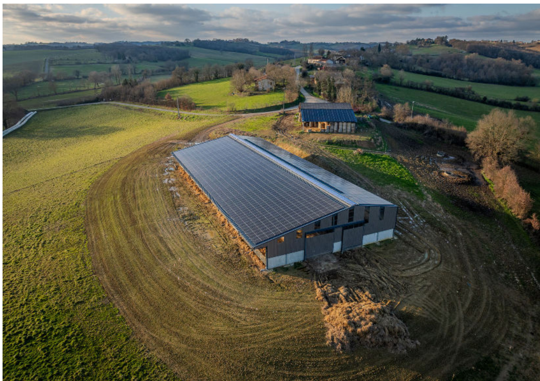
Solarisation de hangar agricole par Arkolia
