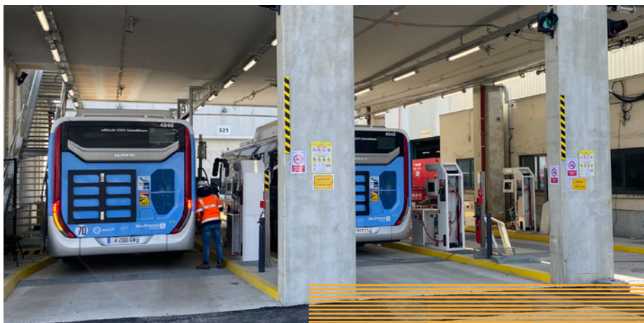
SITE RATP 2025 - PASSAGE DES DÉPÔTS AU BIO-GAZ - MPH ENERGY
