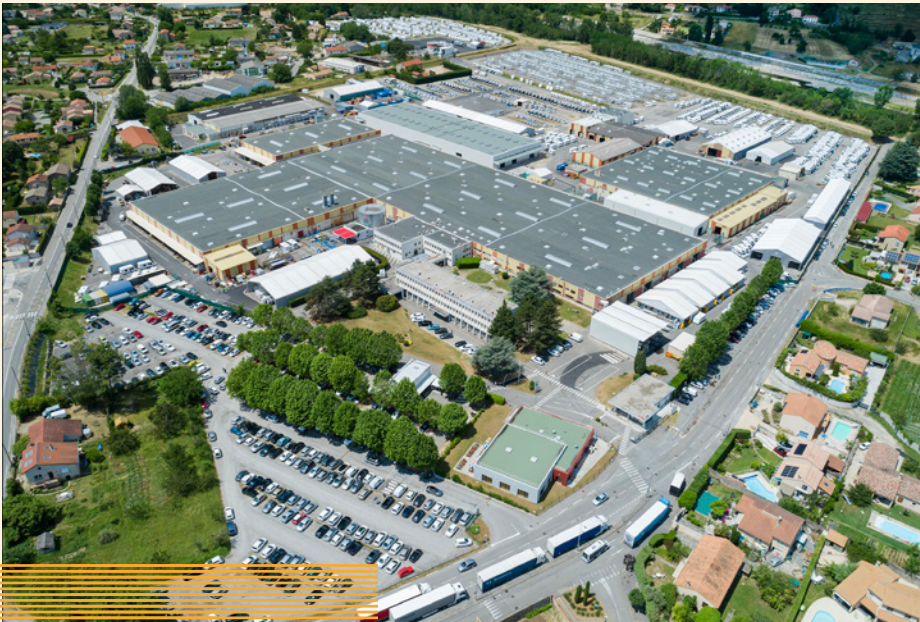
VUE AÉRIENNE DU SITE DE TRIGANO À TOURNON SUR RHÔNE
